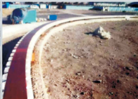
▲ 直径为 42 米的轨道实现整体焊接 The 42m-diameter track achieves overall welding
